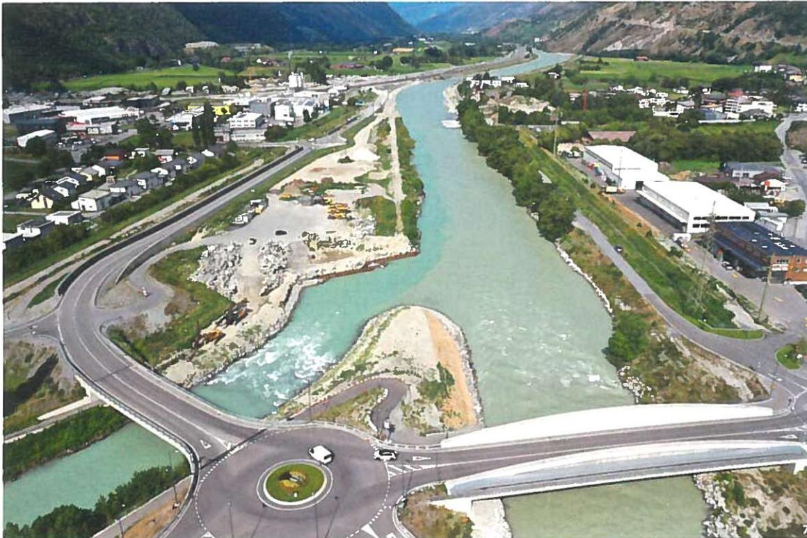
7 Juste en aval du pont amont de Baltschieder, la Vispa se jette dans le Rhône. En rive gauche, les travaux d'élargissement du lit vont bon train. Cette zone est suivie par la digue submersible qui permettra, en cas de crue extrême, de confiner le débordement dans les terres agricoles de la partie supérieure gauche de l'image. (LES IMAGES PROVIENNENT DE L'OCRR3)
